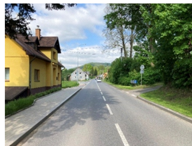
přímý úsek mezi dvěma přechody
