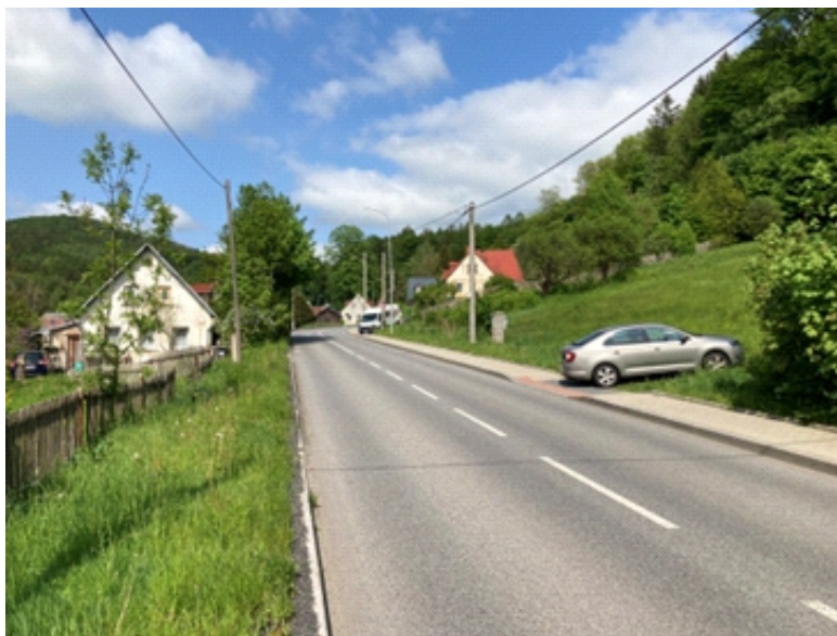
pohled na měřený úsek
